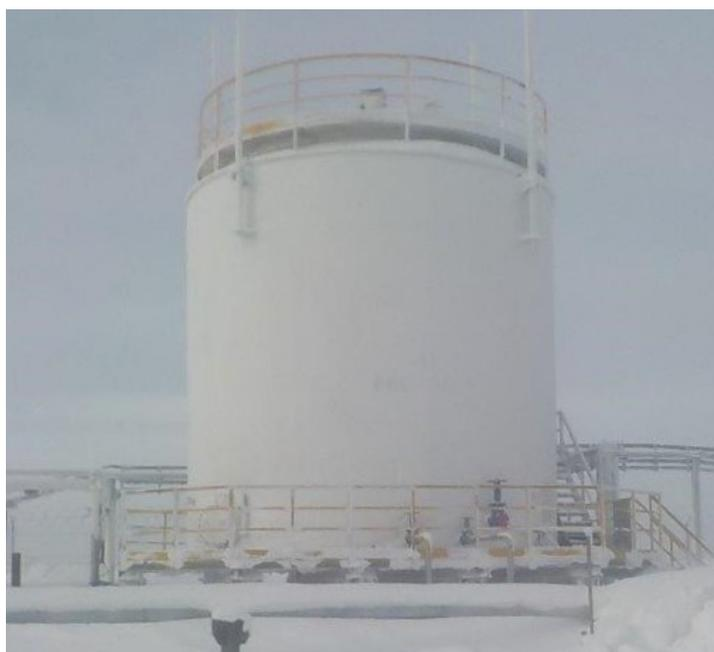
Рисунок 1 – Общий вид резервуара РВС-300
