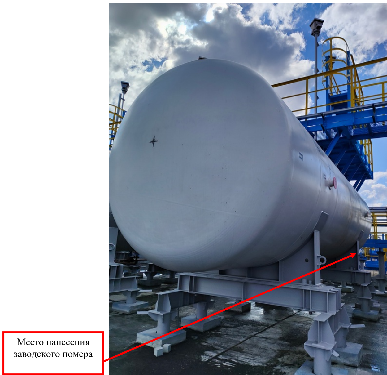
Рисунок 4 - Общий вид резервуара горизонтального стального цилиндрического РГС-50 с заводским номером 21
