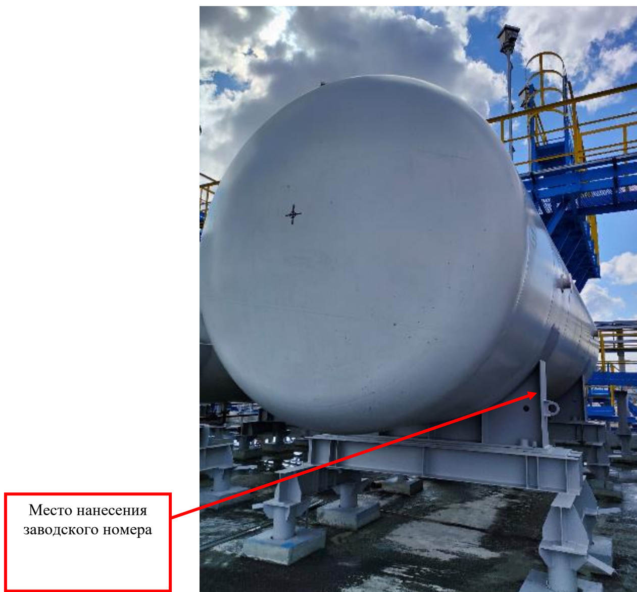
Рисунок 1 - Общий вид резервуара горизонтального стального цилиндрического РГС-50 с заводским номером 18
