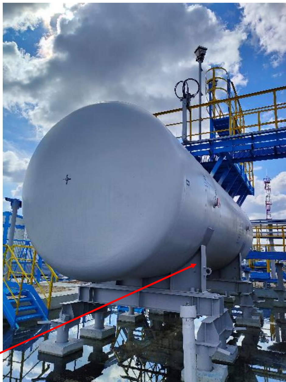
Рисунок 2 - Общий вид резервуара горизонтального стального цилиндрического РГС-50 с заводским номером 19
