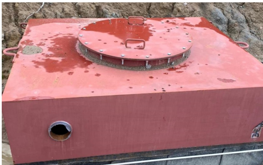
Рисунок 4 – Фото горловины и замерного люка резервуаров РГС-75 зав.№№ 20235, 20236
