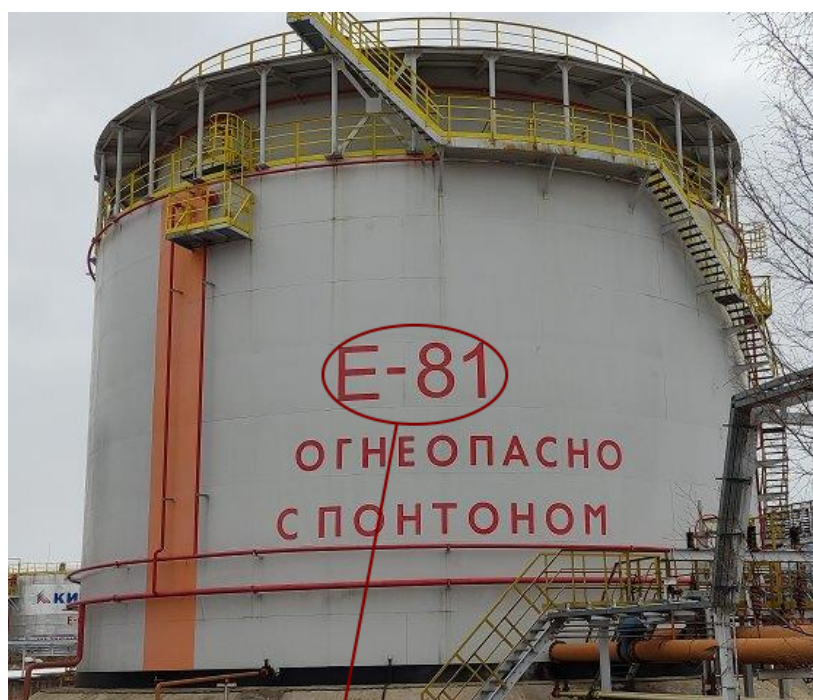
Рисунок 1 – Общий вид резервуара РВСП-5000 с указанием места нанесения заводского номера
