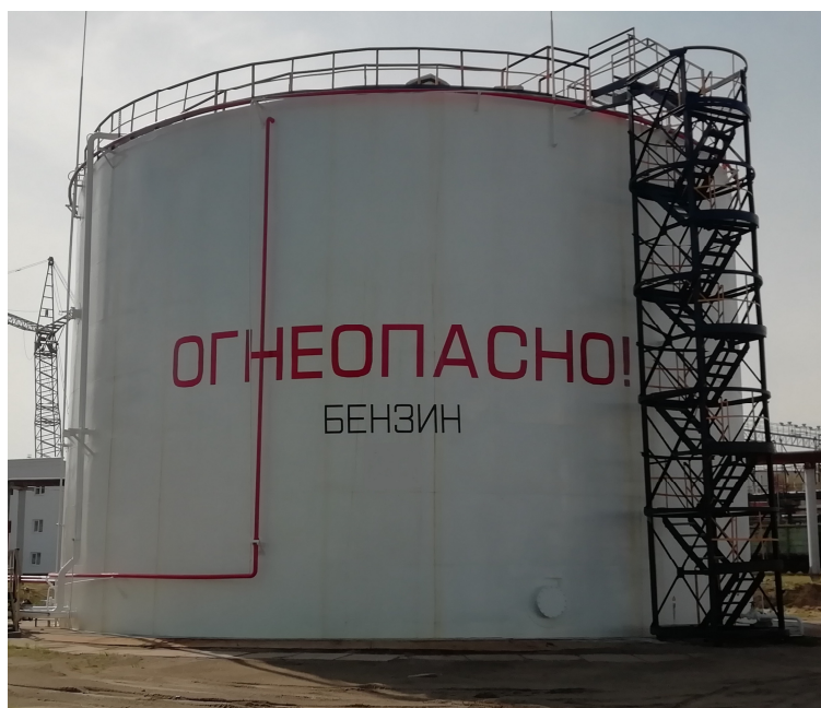
Рисунок 1 – Общий вид резервуаров РВС-3000
