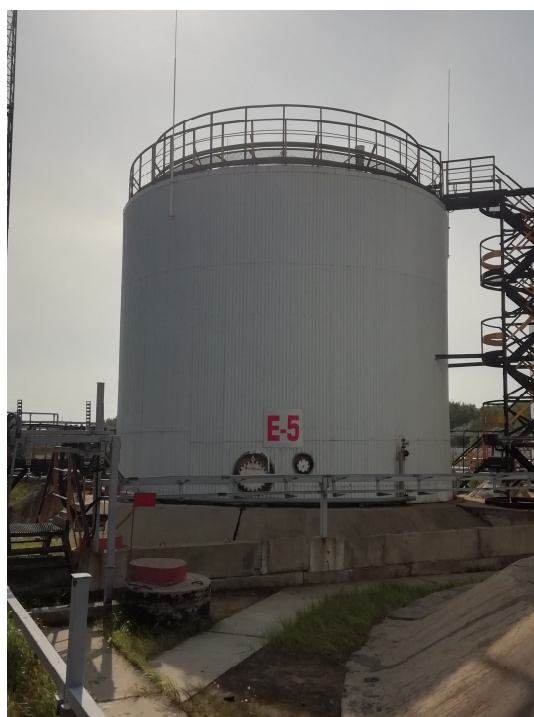
Рисунок 1 – Общий вид резервуаров РВС-700
