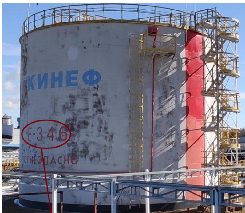
Рисунок 1 – Общий вид резервуара РВС-2000 № Е-345 с указанием места нанесения заводского номера
