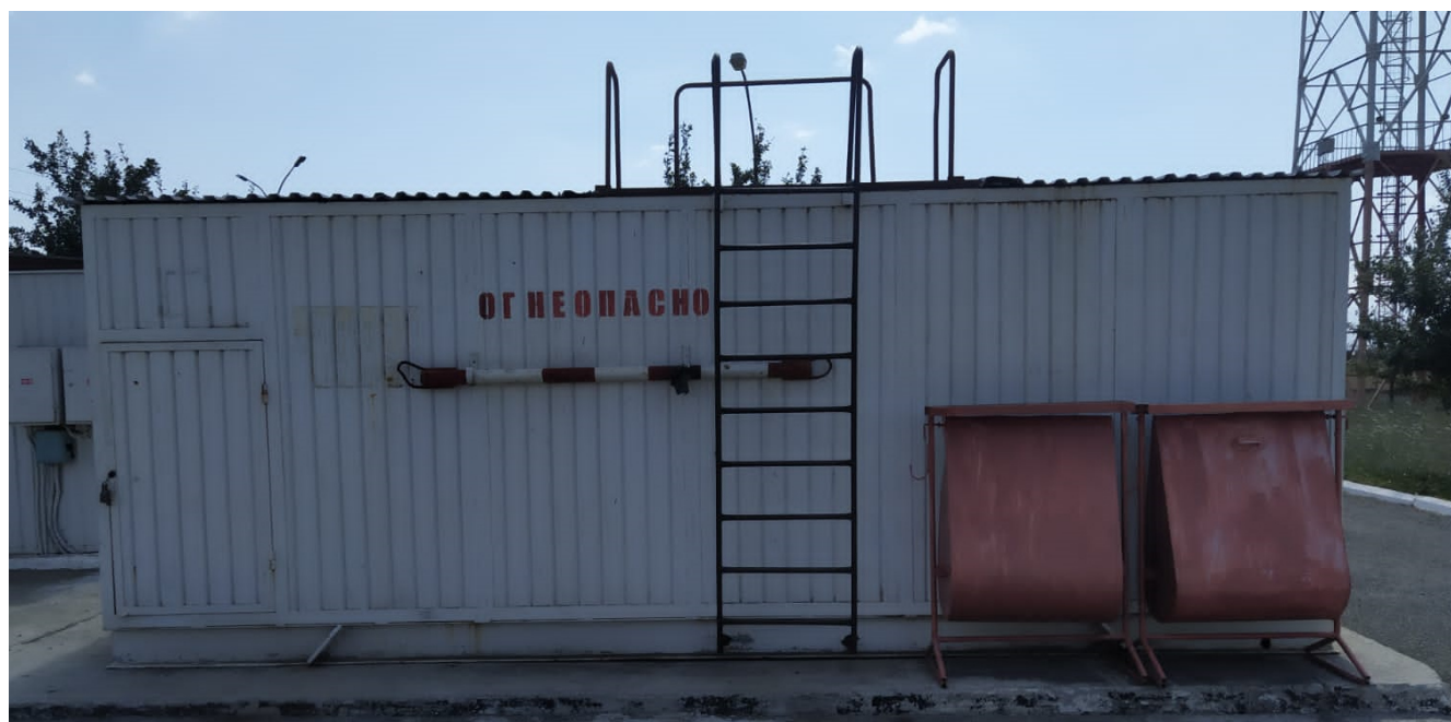
Рисунок 1 – Место расположения резервуаров РГС-5 с заводскими номерами 69/1, 69/2
