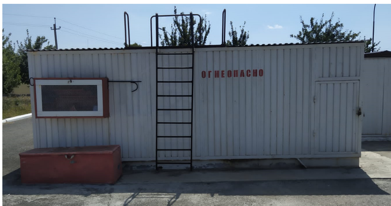
Рисунок 2 – Место расположения резервуаров РГС-5 с заводскими номерами 72/1, 72/2
