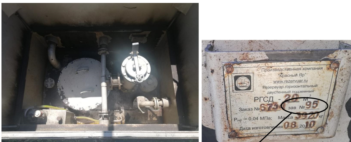
Рисунок 2 – Общий вид резервуара РГСД-20 №94 с указанием места нанесения заводского номера
