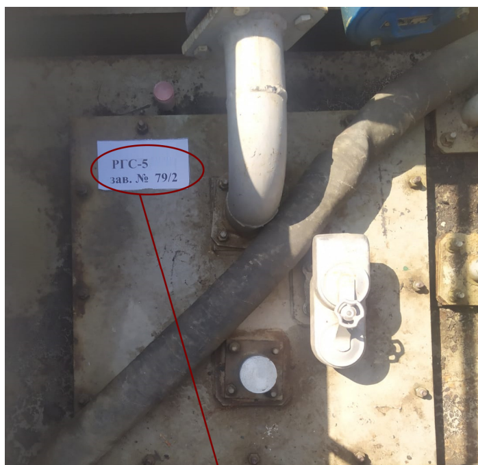
Рисунок 6 – Общий вид резервуара РГС-5 зав.№ 79/2 с указанием места нанесения заводского номера
