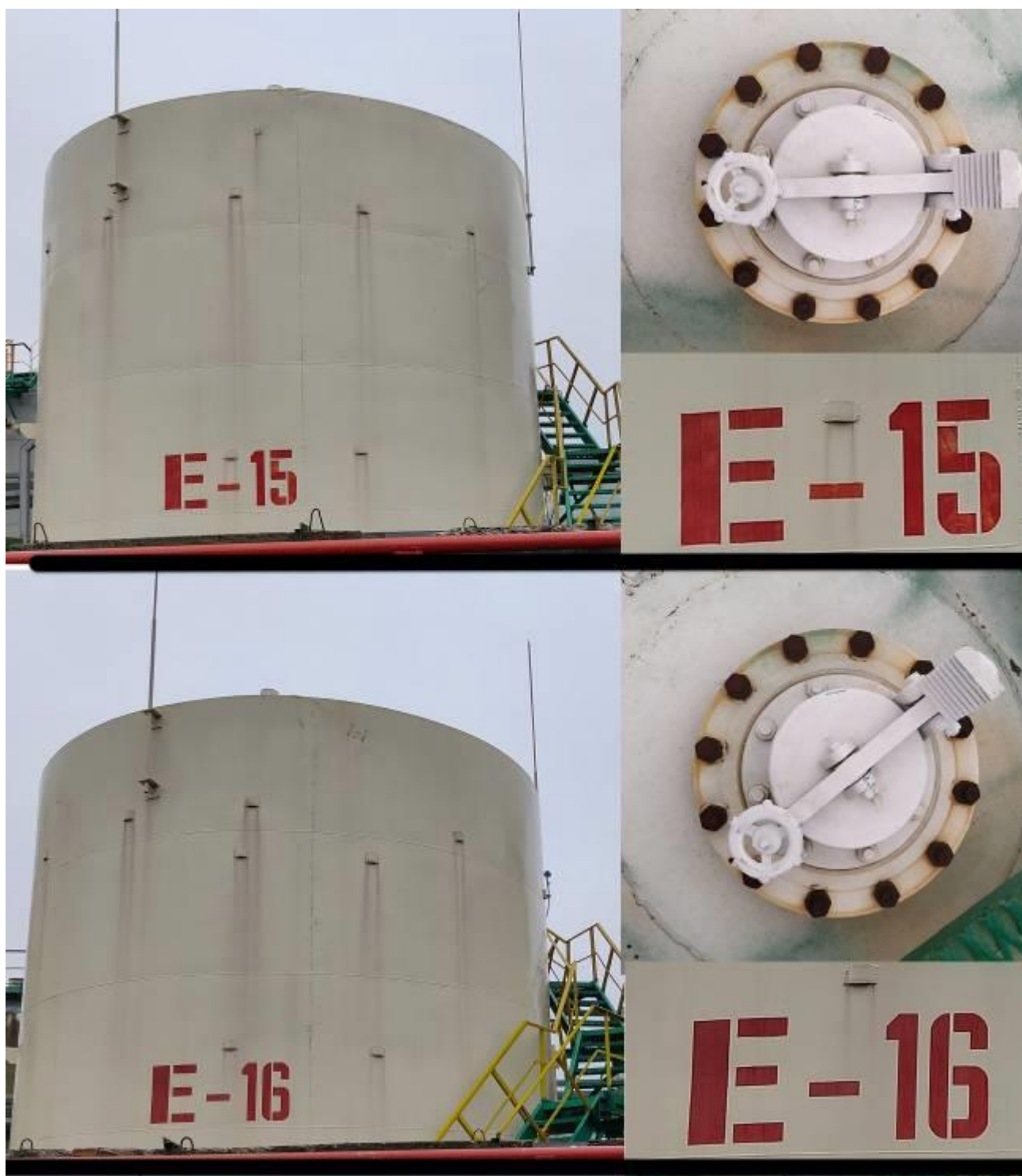
Рисунок 1 – Общий вид резервуаров стальных вертикальных цилиндрических РВС-200 №№ E15, E16 их горловин и заводских номеров
