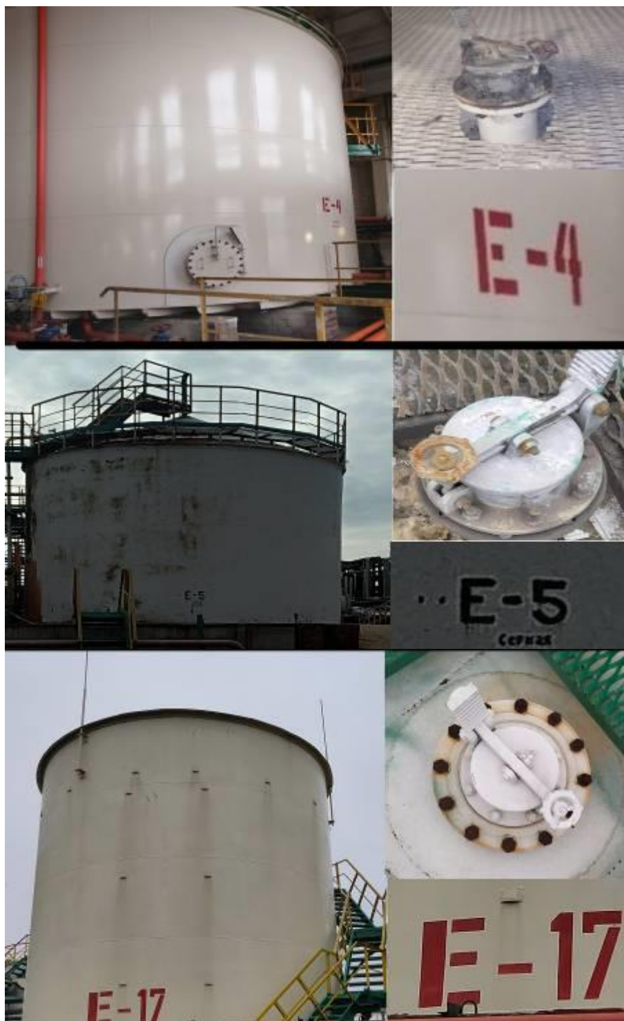
Рисунок 3 – Общий вид резервуаров стальных вертикальных цилиндрических РВС-300 №№ E-4, E-5, E-17 их горловин и заводских номеров
