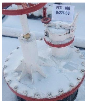
Рисунок 6 – Фотография горловины и заводского номера резервуара стального горизонтального цилиндрического РГС-100, заводской номер 224-60
