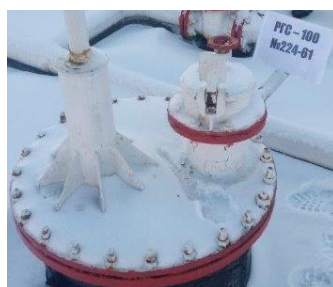
Рисунок 7 – Фотография горловины и заводского номера резервуара стального горизонтального цилиндрического РГС-100, заводской номер 224-61
