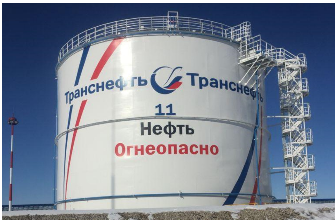
Рисунок 1 – Общий вид резервуара РВС-5000
