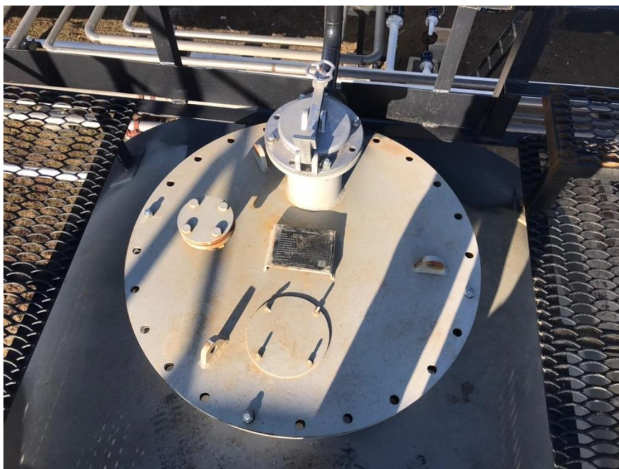
Рисунок 8 – Горловины и замерной люк резервуара РГСН-50, зав. №234/2.
