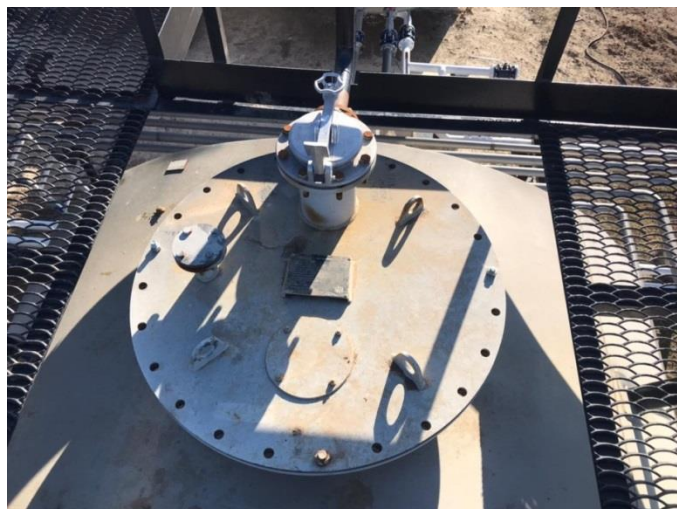
Рисунок 2 – Горловины и замерной люк резервуара РГСН-75, зав. №233/1.
