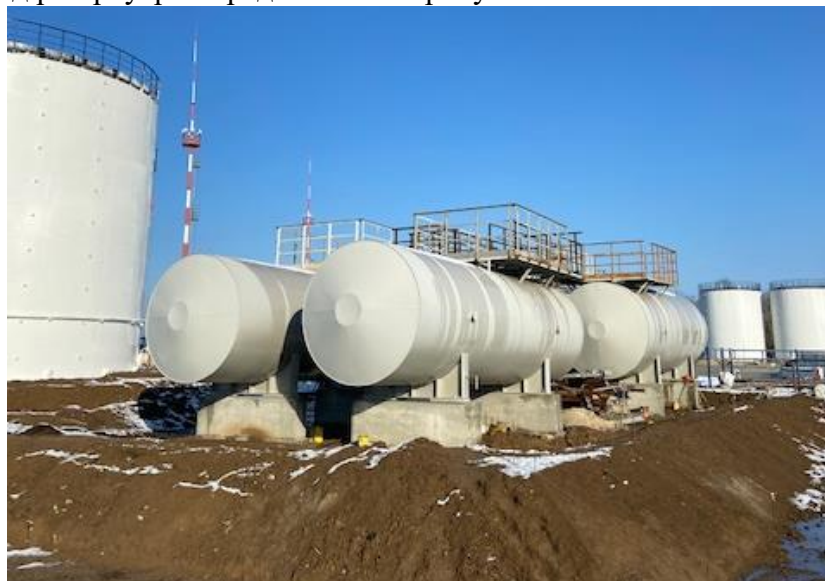
Рисунок 1 – Общий вид резервуаров.
