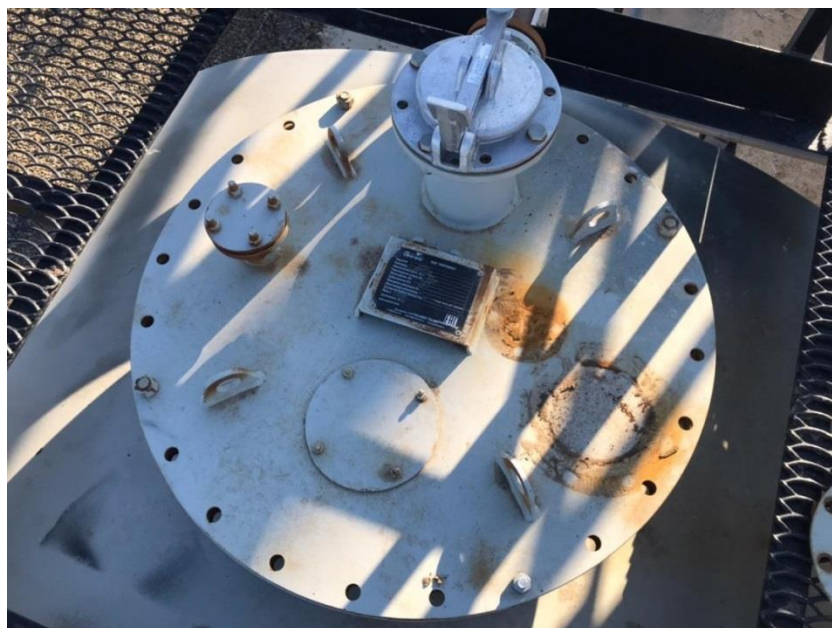
Рисунок 4 – Горловины и замерной люк резервуара РГСН-75, зав. №233/2.
