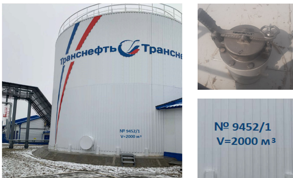
Рисунок 1 – Общий вид резервуара вертикального стального РВС-2000 с заводским номером 9452/1
