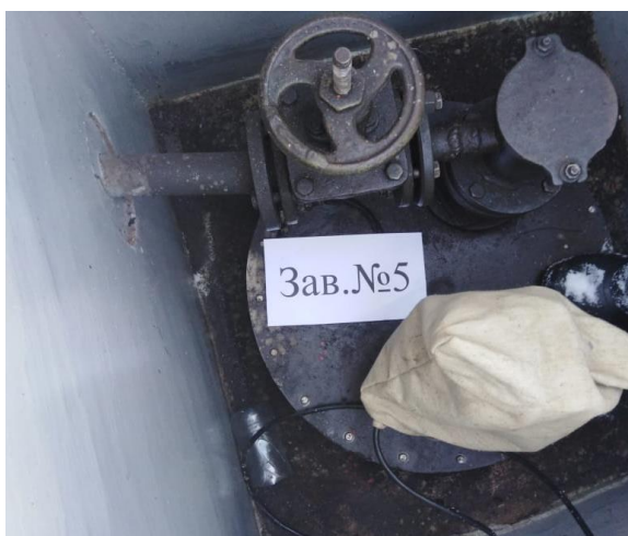
Рисунок 1 – Общий вид резервуара РГС-10
