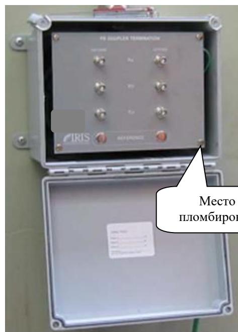
Рисунок 4 – Общий вид соединительной коробки выводов с местом пломбировки от несанкционированного доступа
