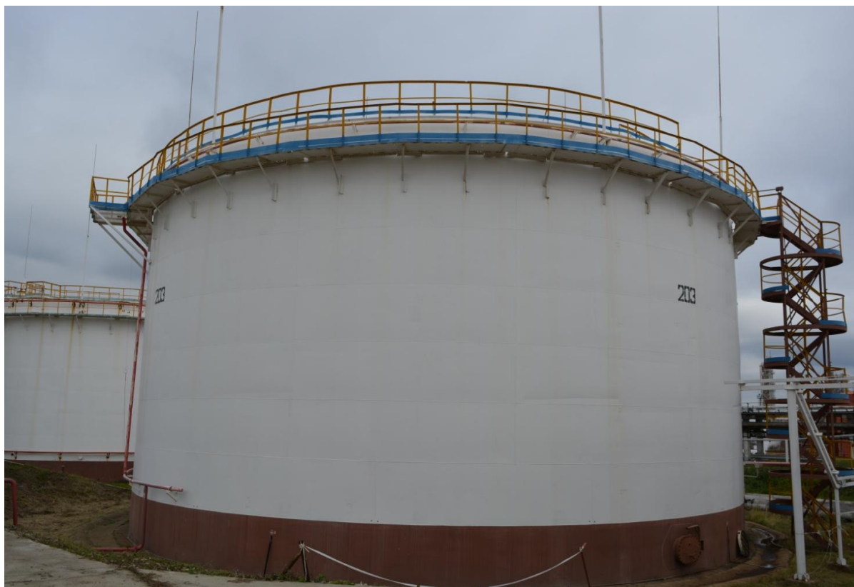
Рисунок 6 - Общий вид резервуара РВСП-5000 № 203
