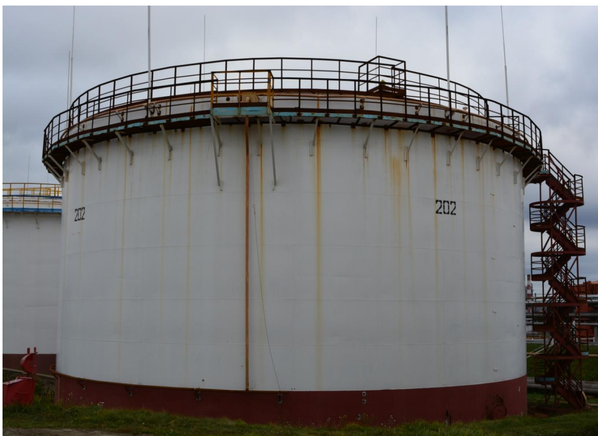
Рисунок 5 - Общий вид резервуара РВСП-5000 № 202
