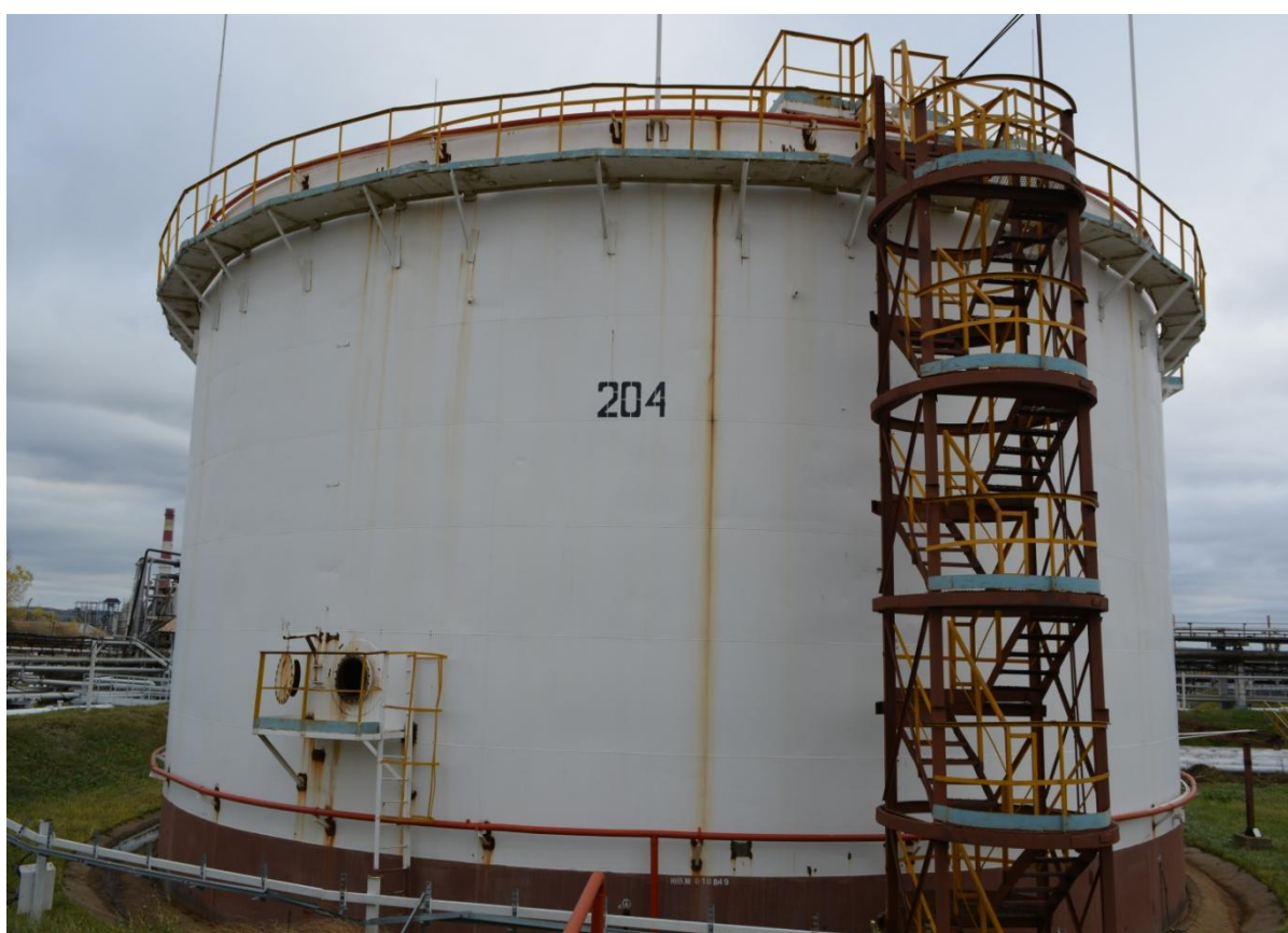
Рисунок 7 - Общий вид резервуара РВСП-5000 № 204
