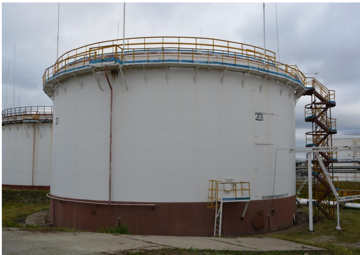
Рисунок 4 - Общий вид резервуара РВСП-5000 №201
