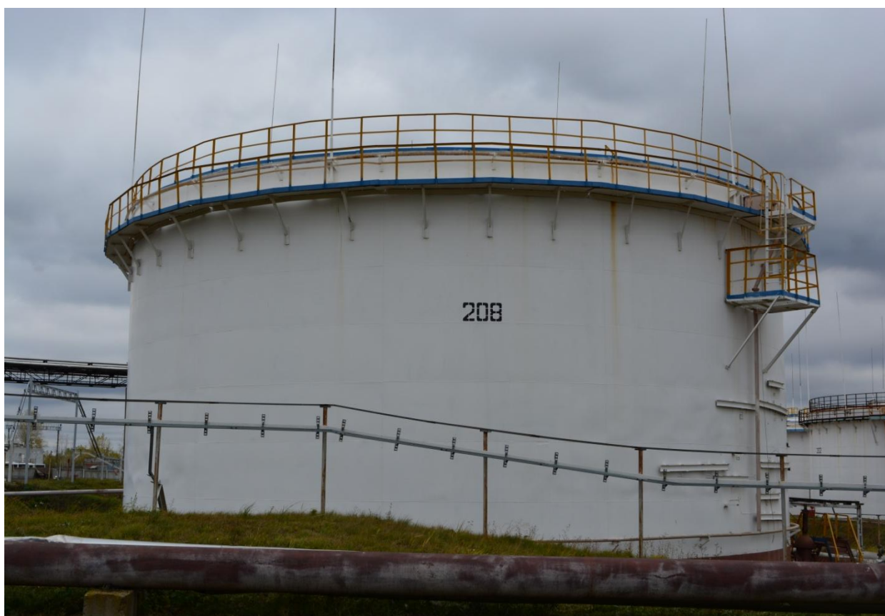
Рисунок 11 - Общий вид резервуара РВСП-5000 № 208
