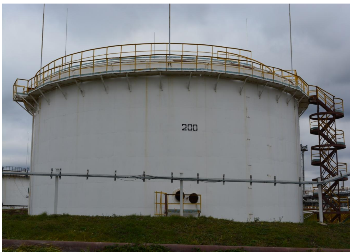
Рисунок 3 - Общий вид резервуара РВСП-5000 № 200
