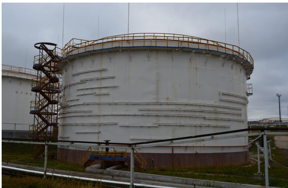
Рисунок 9 - Общий вид резервуара РВСП-5000 № 206
