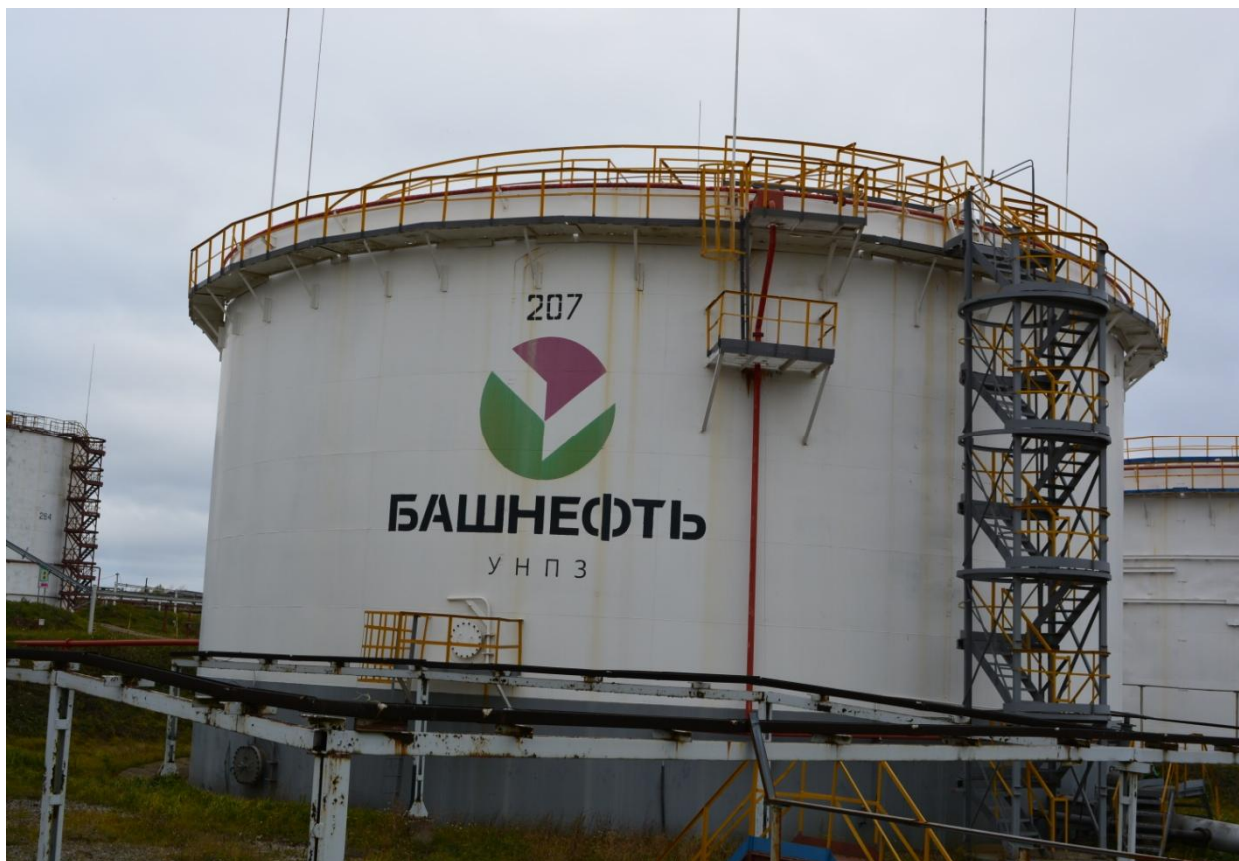
Рисунок 10 - Общий вид резервуара РВСП-5000 № 207
