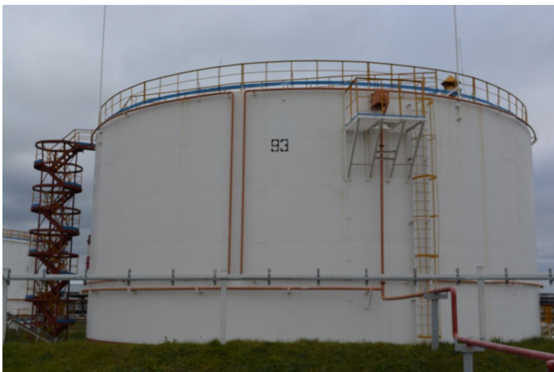
Рисунок 1 - Общий вид резервуара РВСП-5000 № 93
