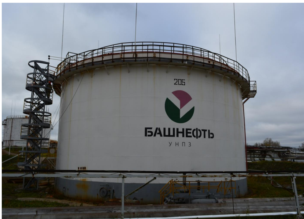
Рисунок 8 - Общий вид резервуара РВСП-5000 № 205
