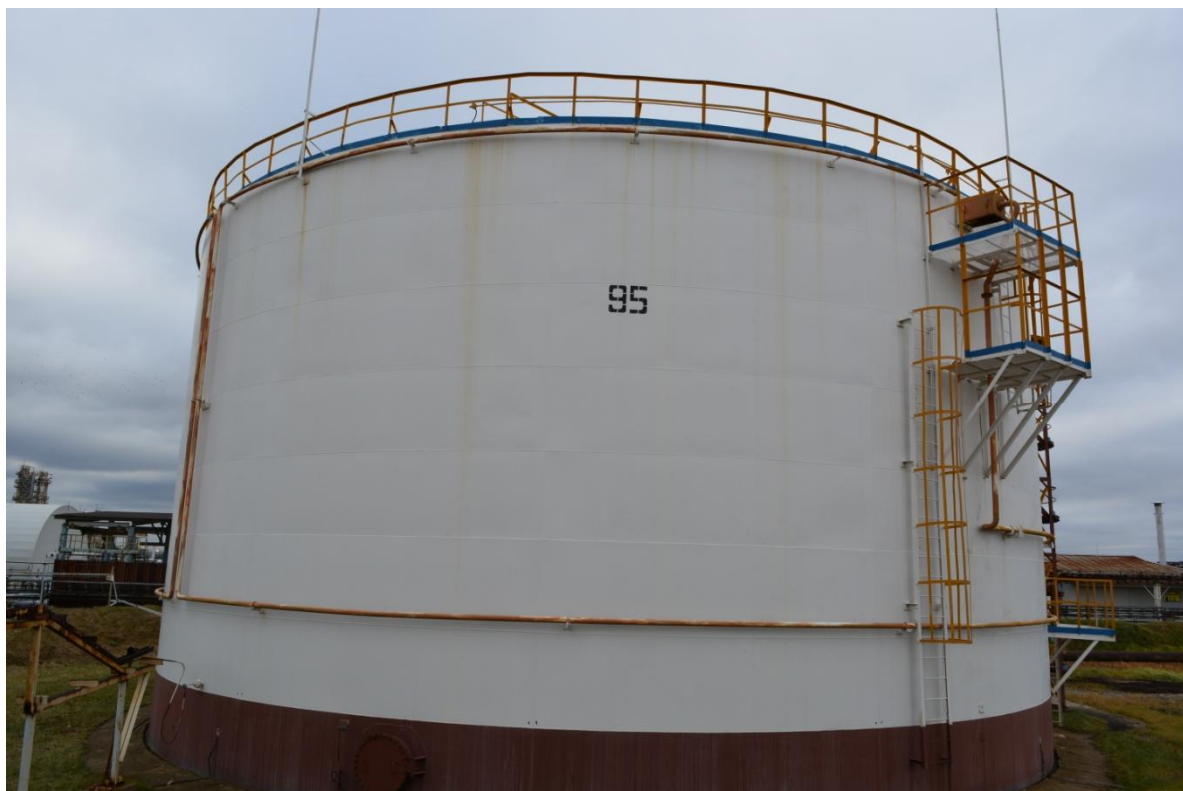
Рисунок 2 - Общий вид резервуара РВСП-5000 № 95
