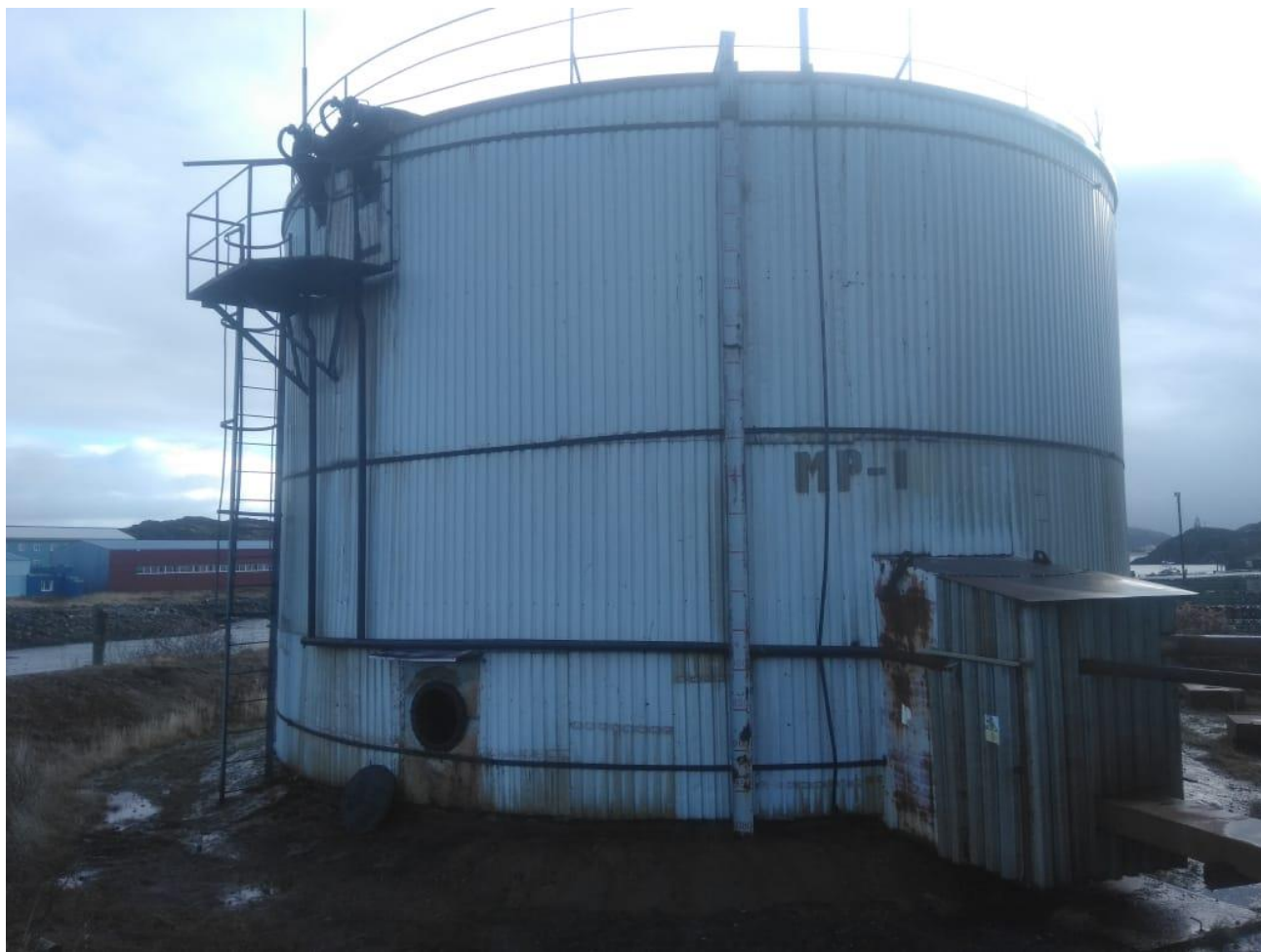
Рисунок 1 – Общий вид резервуара РВС-1000
