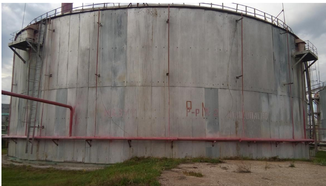
Рисунок 1 - Общий вид резервуара стального вертикального цилиндрического РВС-10000 № 2
