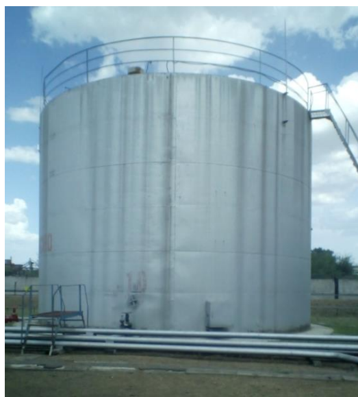
Рисунок 1 – Общий вид резервуара РВС-1000
