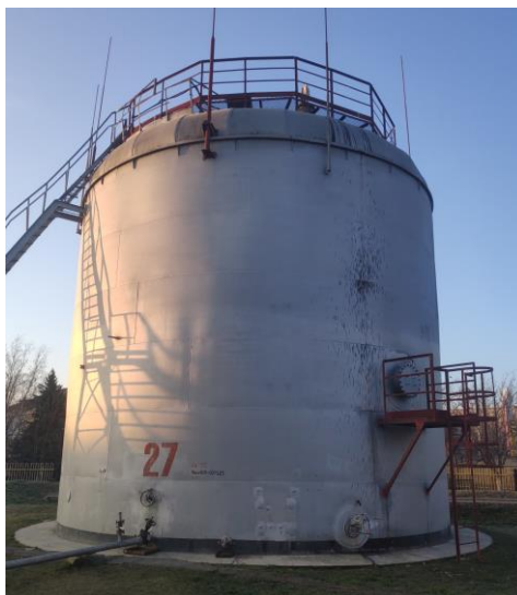
Рисунок 1 – Общий вид резервуара РВСП-700
