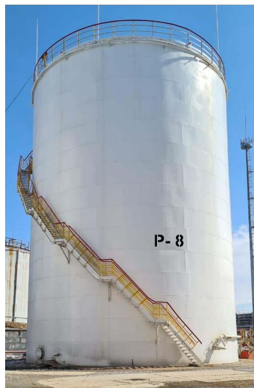
Рисунок 4 – Общий вид резервуара с зав. № 8
