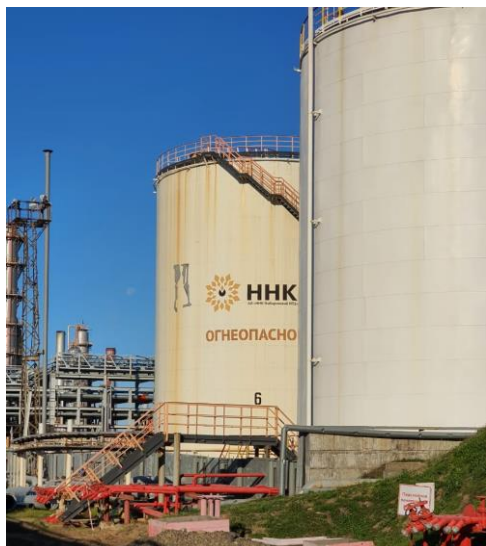
Рисунок 1 – Общий вид резервуара с зав. № 6
