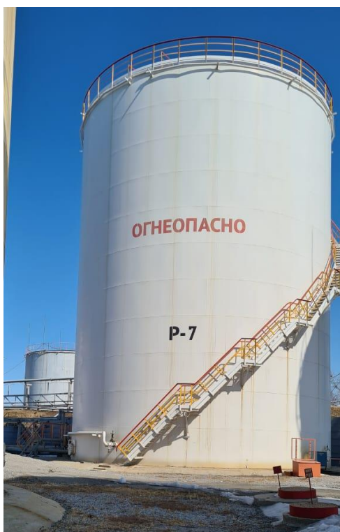
Рисунок 3 – Общий вид резервуара с зав. № 7
