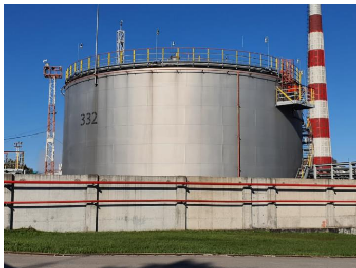
Рисунок 2 – Общий вид резервуара с зав. № 332
