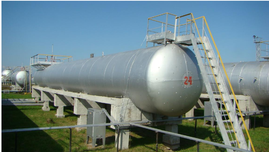
Рисунок 1 - Общий вид резервуаров стальных горизонтальных цилиндрических РГС-175
