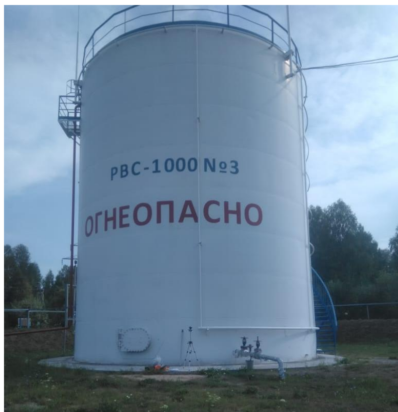
Рисунок 2 – Общий вид резервуара РВС-1000 с заводским номером 01164/1
