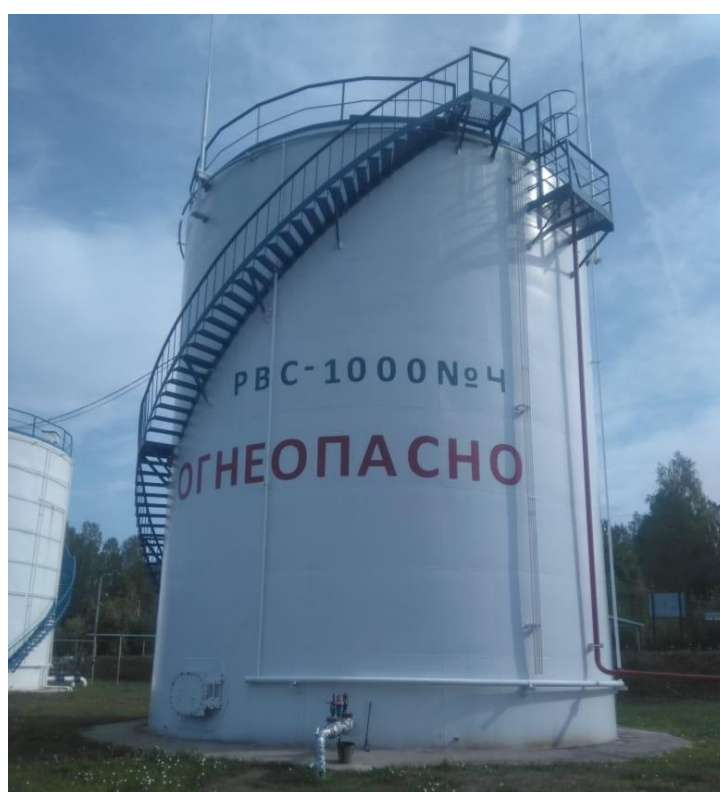
Рисунок 3 – Общий вид резервуара РВС-1000 с заводским номером 01292/1
