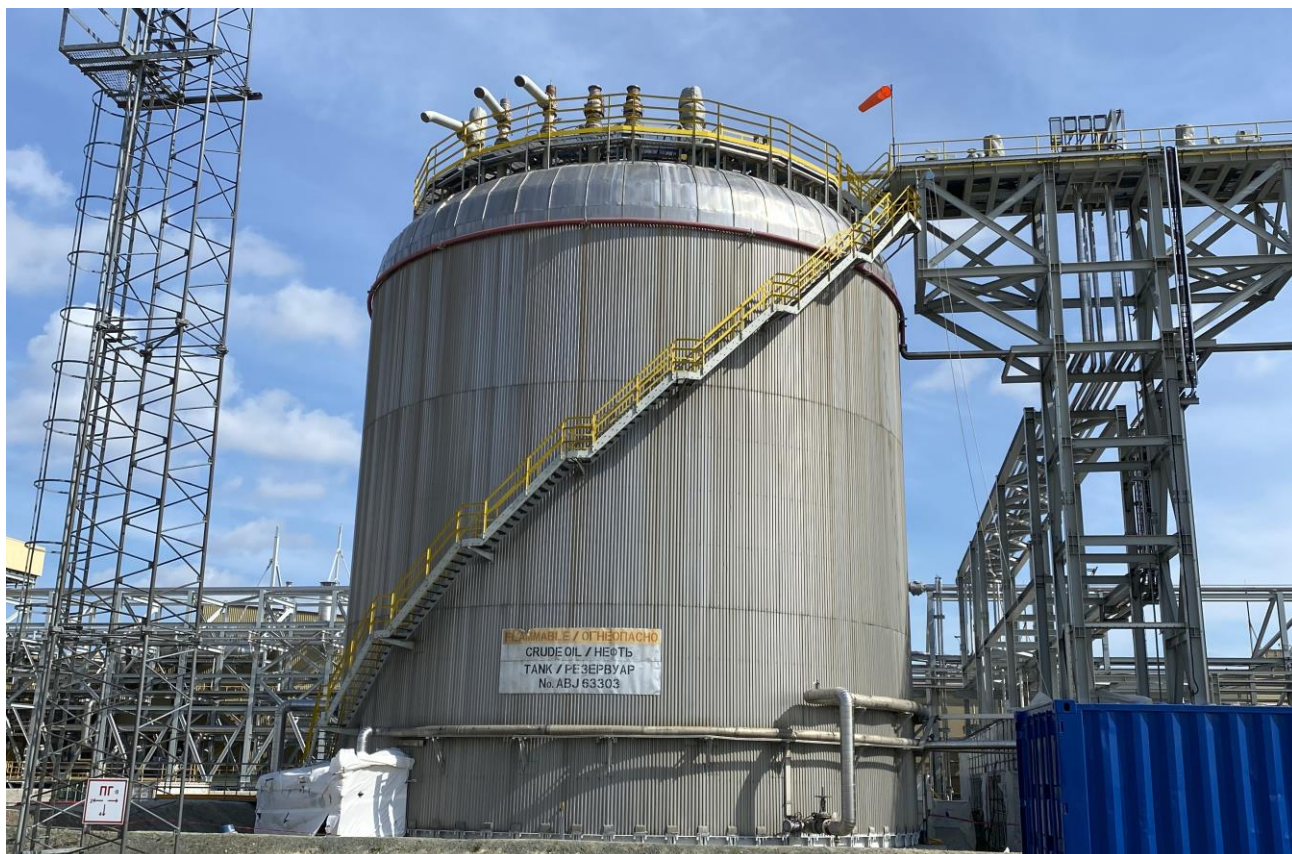
Рисунок 2 – Общий вид резервуара РВС-5000
