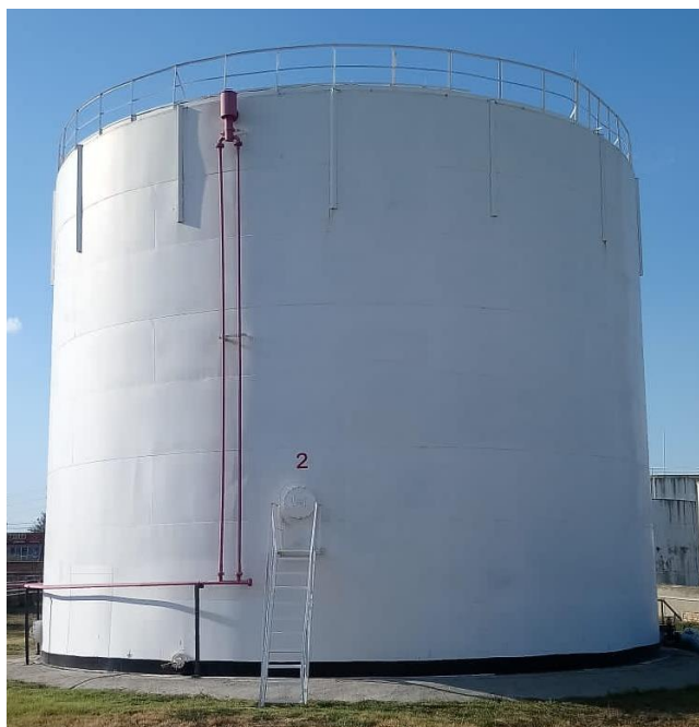
Рисунок 2 – Общий вид резервуара РВСП-2000
