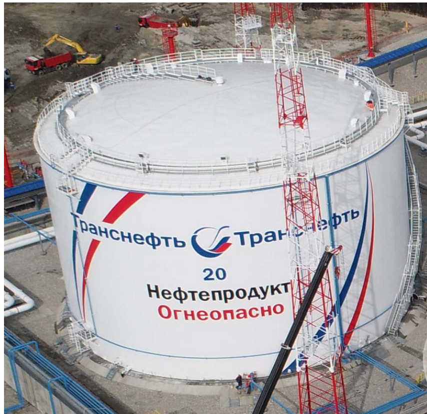
Рисунок 1 – Общий вид резервуара РВСП-30000 зав. № 20
