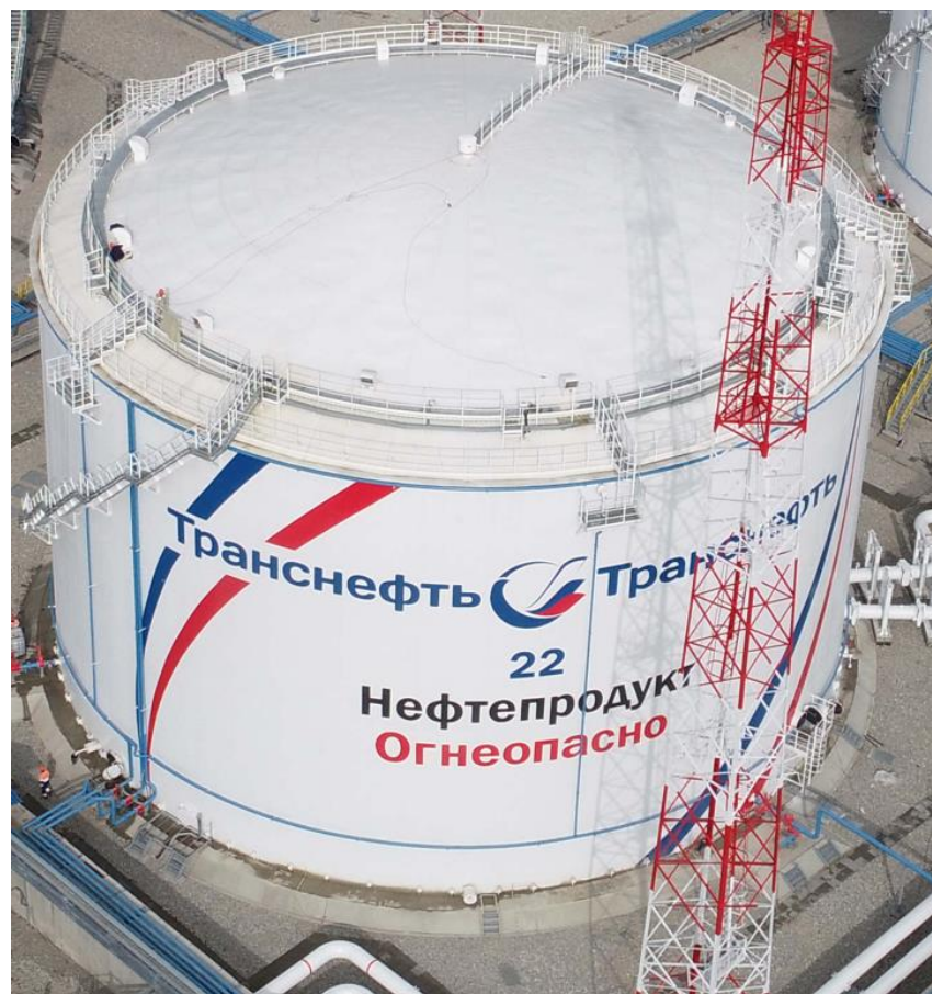
Рисунок 2 – Общий вид резервуара РВСП-30000 зав. № 22
