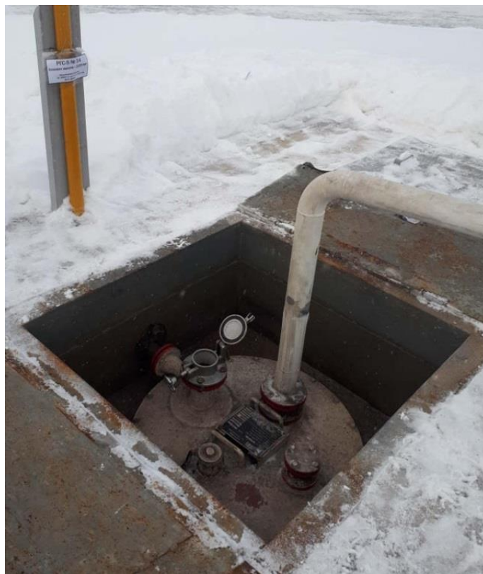
Рисунок 1 – Общий вид резервуара РГС-5
