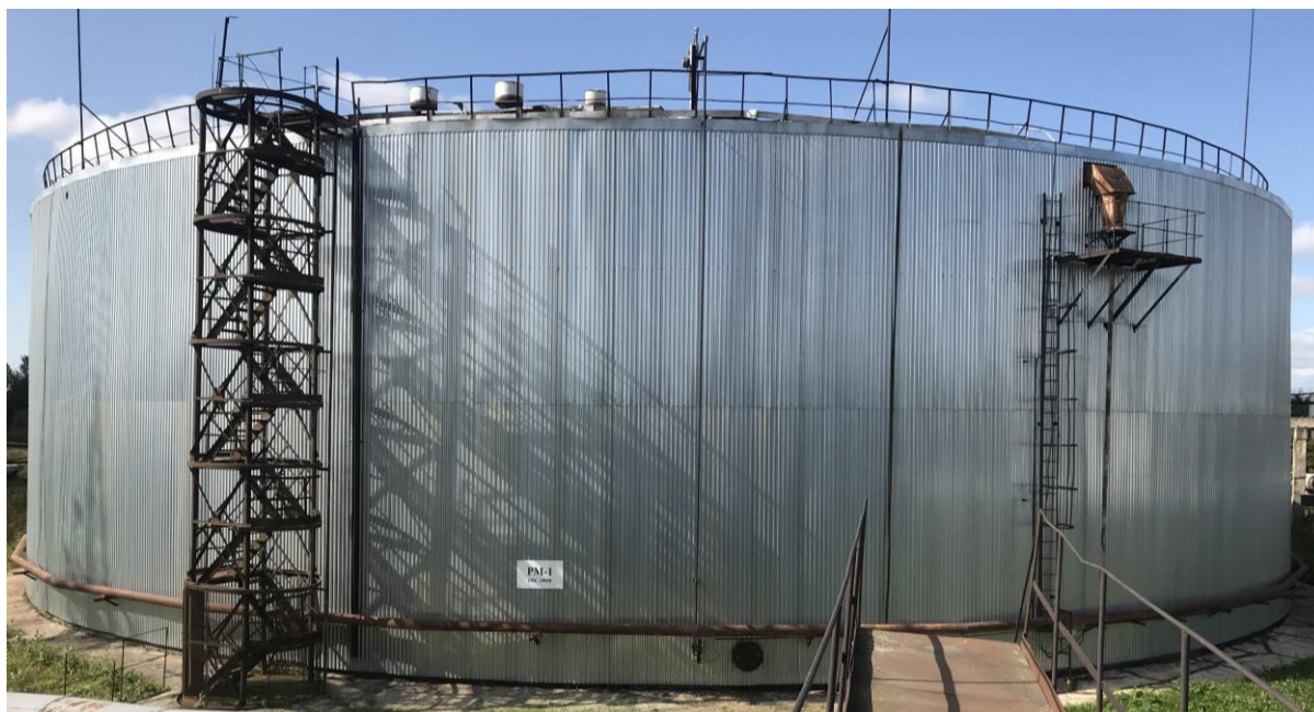
Рисунок 1 – Общий вид резервуара РВС-20000
