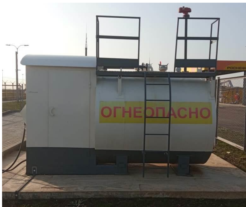
Рисунок 1 – Общий вид резервуара
