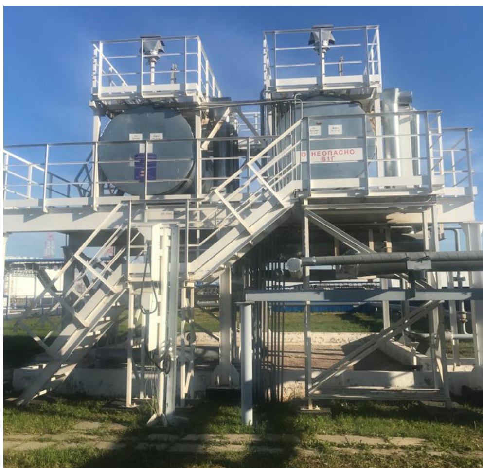
Рисунок 2 – Общий вид резервуаров РГС-20
