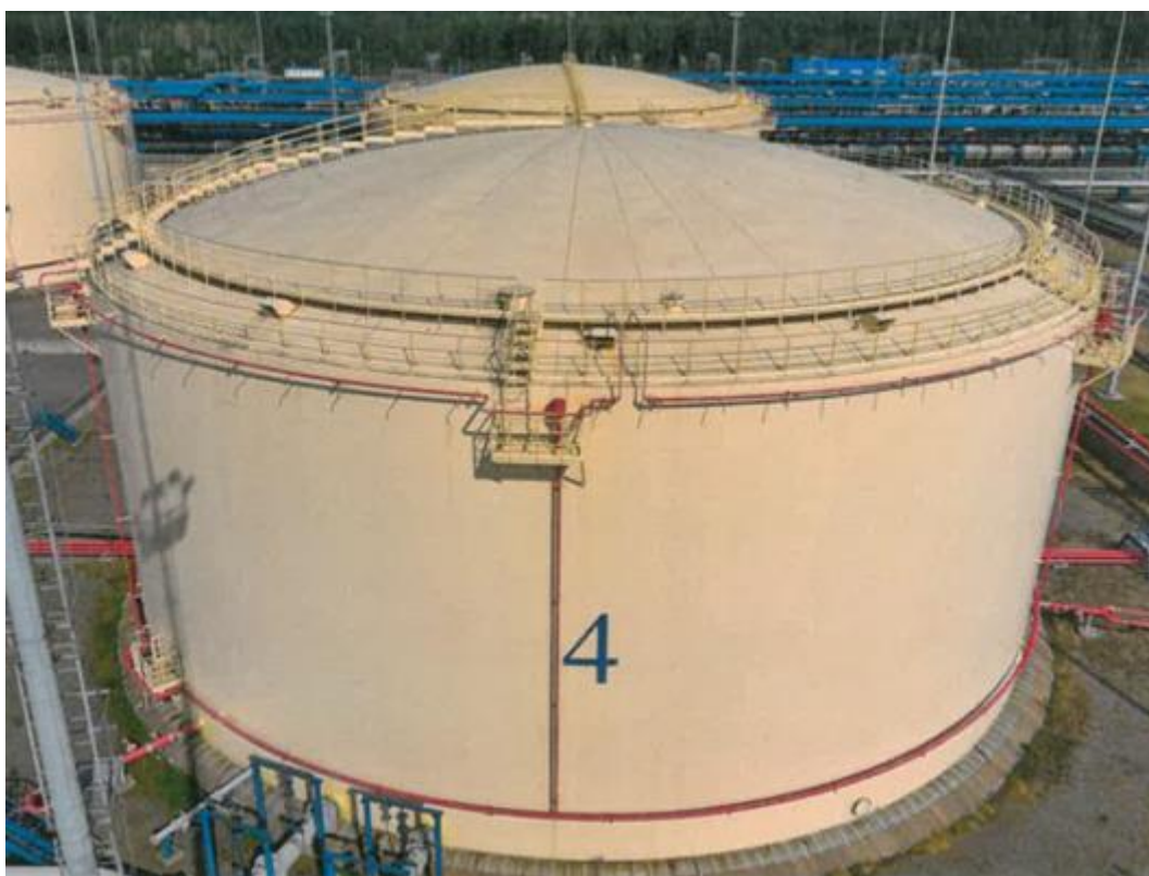
Рисунок 4 – Общий вид резервуара РВСП-30000 зав. № 4
