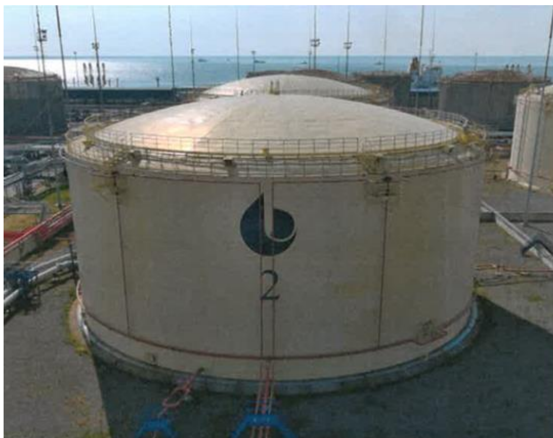
Рисунок 2 – Общий вид резервуара РВСП-30000 зав. № 2
