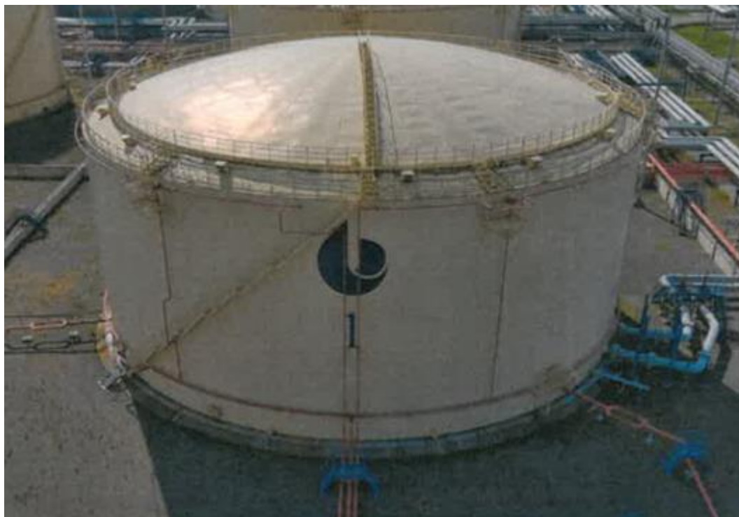
Рисунок 1 – Общий вид резервуара РВСП-30000 зав. № 1
