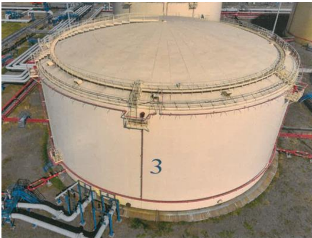
Рисунок 3 – Общий вид резервуара РВСП-30000 зав. № 3
