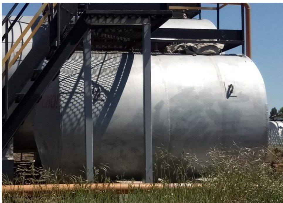
Рисунок 1 – Общий вид резервуара
