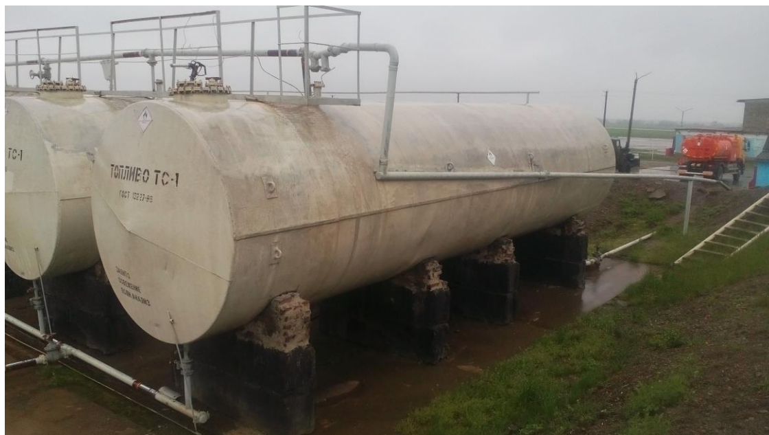
Рисунок 1 – Общий вид резервуаров РГС-60
