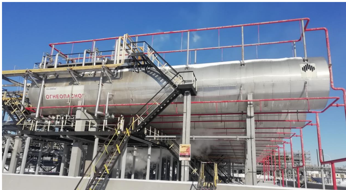
Рисунок 2 – Общий вид резервуаров РГС-200
