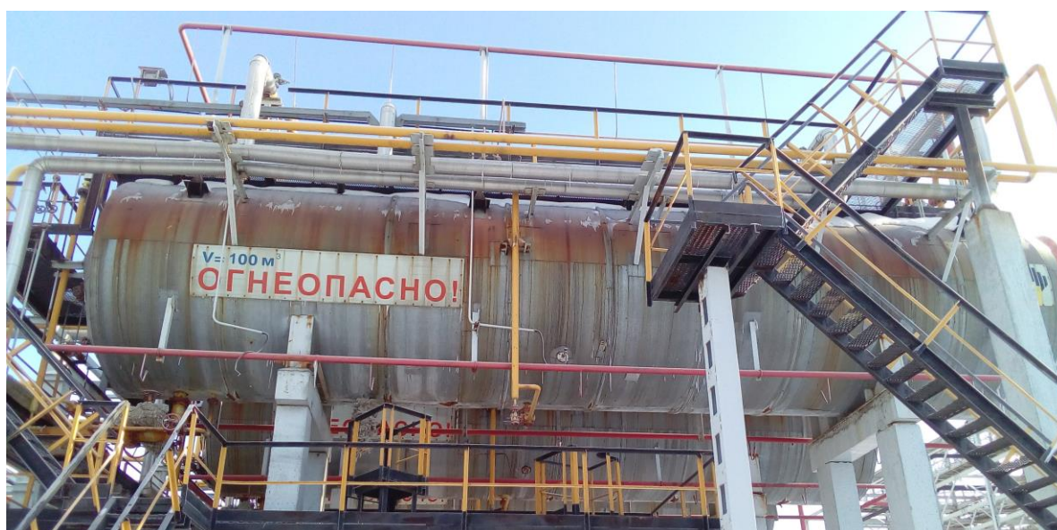
Рисунок 1 – Общий вид резервуаров РГС-100
