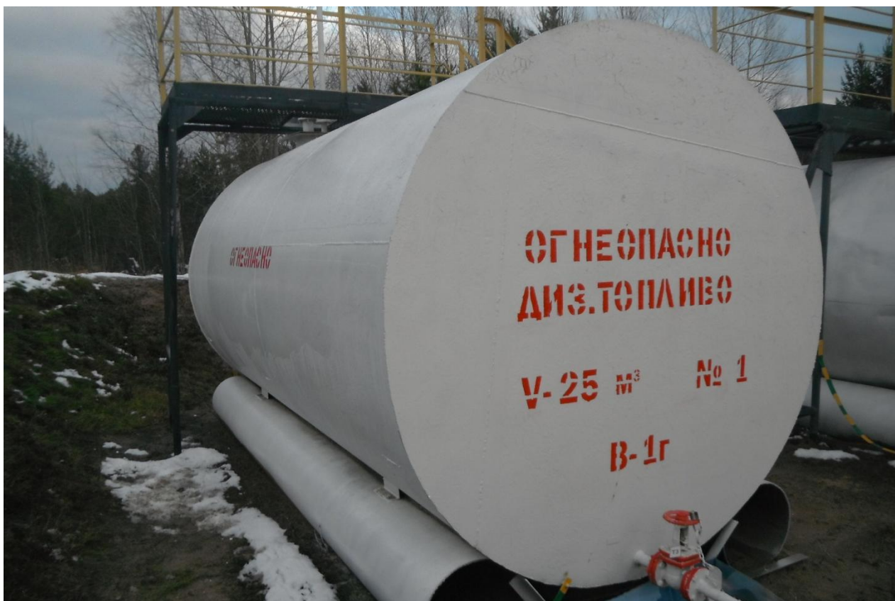
Рисунок 1 - Общий вид резервуара
