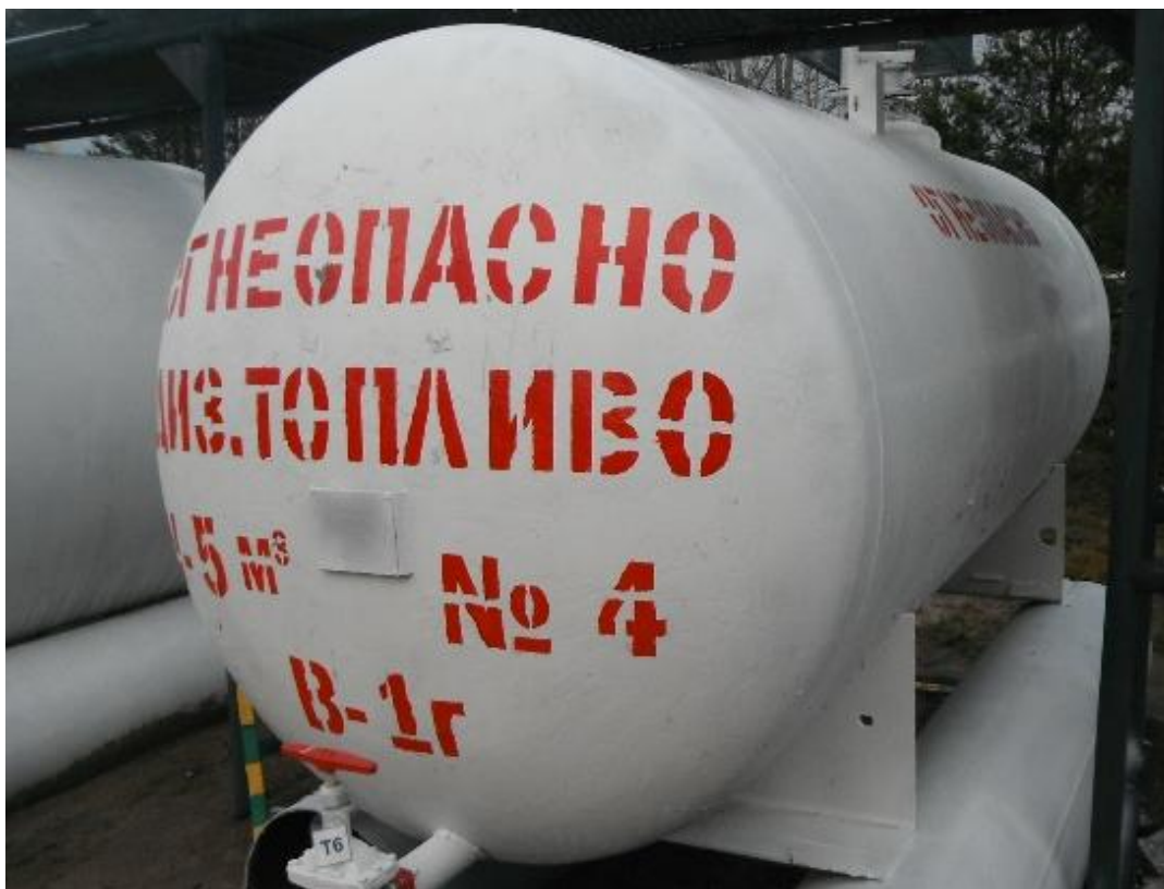
Рисунок 1 - Общий вид резервуаров стальных горизонтальных цилиндрических РГС-5, РГС-10
