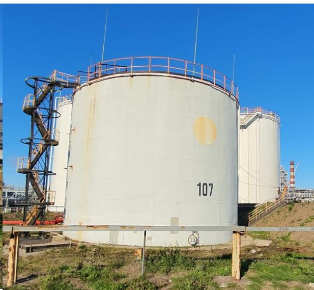
Рисунок 2 – Общий вид резервуара с зав. № 107
