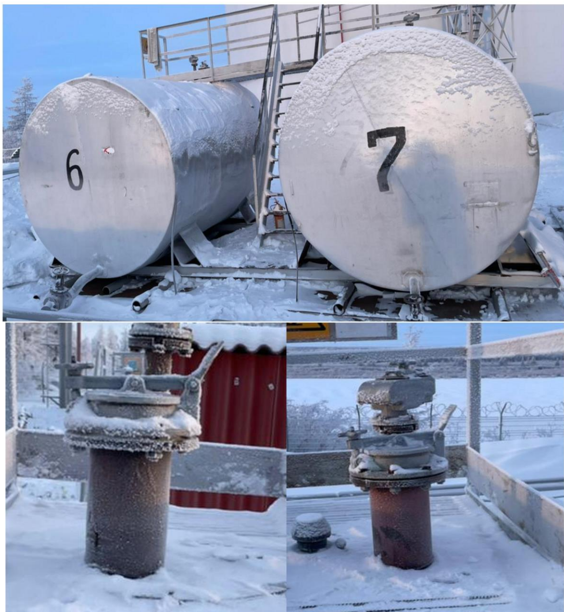
Рисунок 1 – Общий вид резервуаров РГС-25 с заводскими номерами 6, 7
