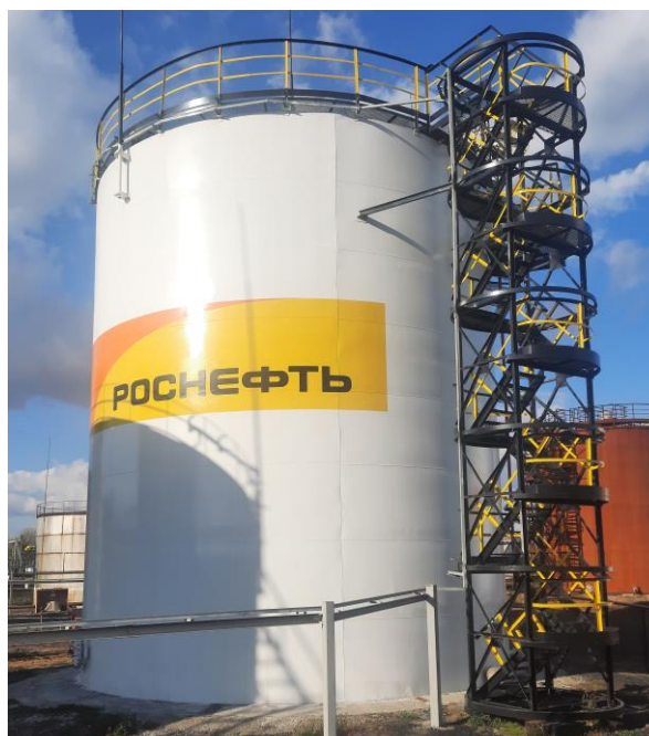
Рисунок 1 – Общий вид резервуаров РВСП-1000
