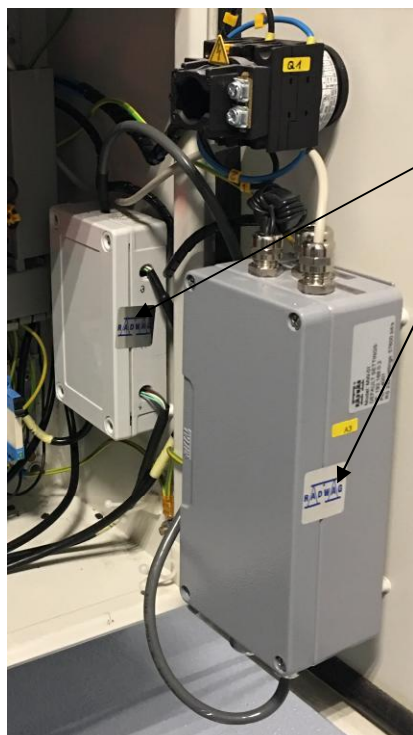
Рисунок 13 - Схема пломбировки от несанкционированного доступа в настройки весов автоматического действия DWT/RC xxx ABC, DWR xxxxx ABC, DWT/HL xxxxx ABC
