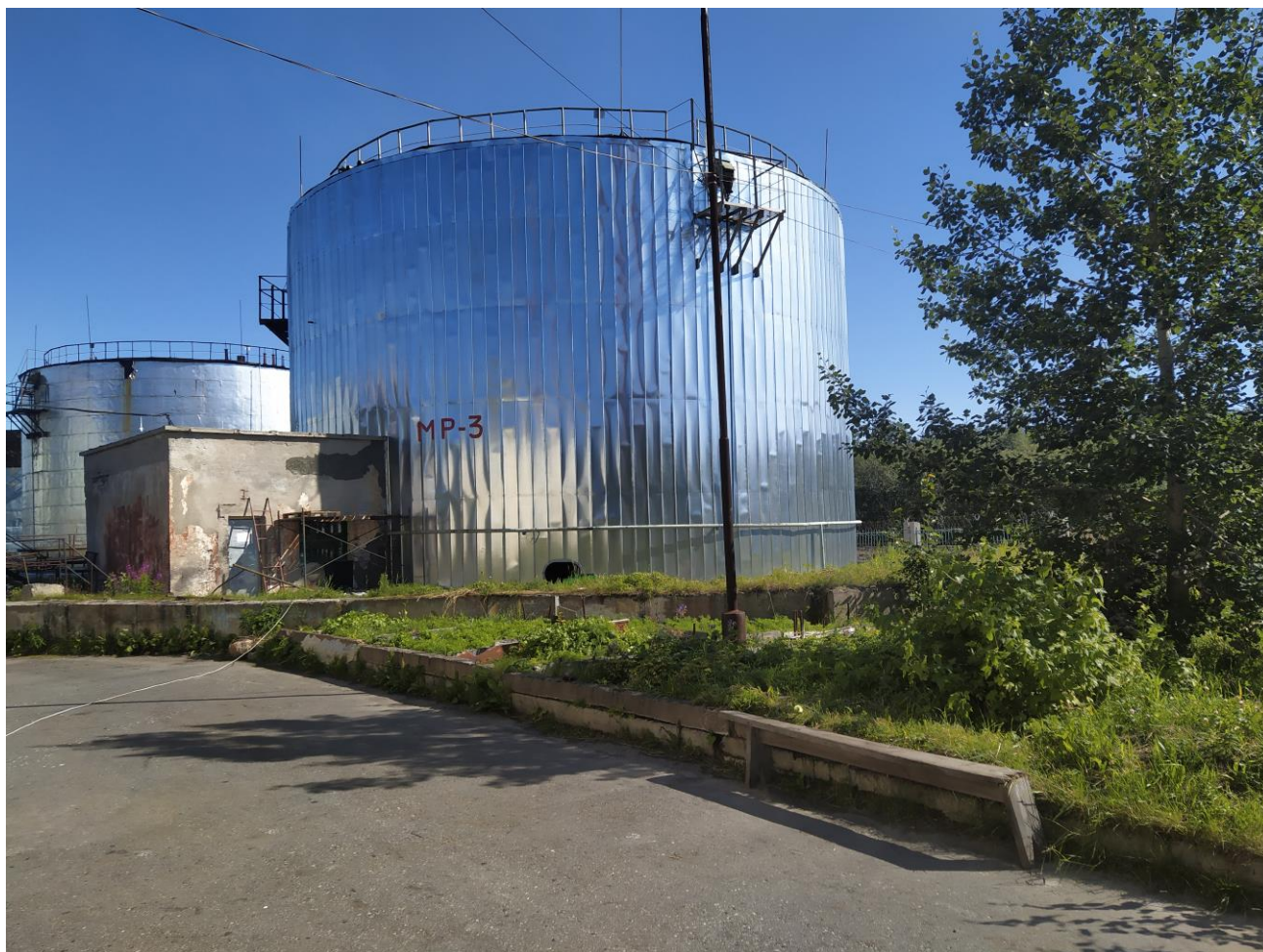
Рисунок 1 – Общий вид резервуара РВС-3000
