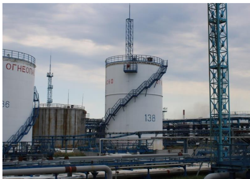
Рисунок 1 – Общий вид резервуара
