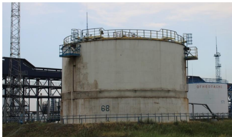
Рисунок 1 – Общий вид резервуара
