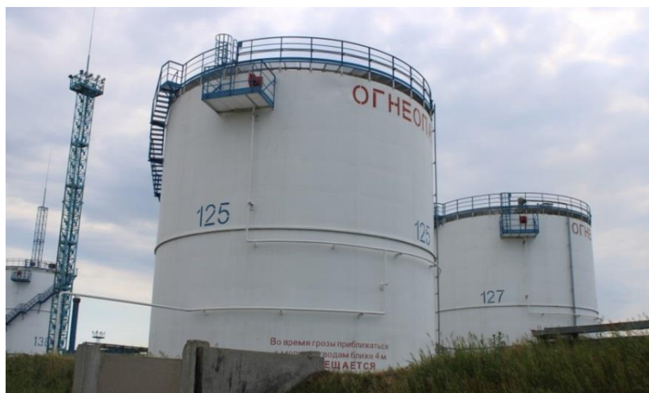
Рисунок 1 – Общий вид резервуара
