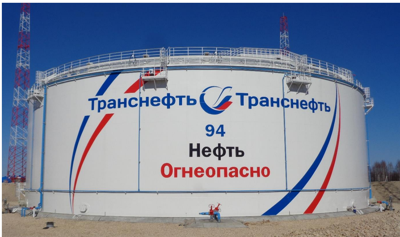
Рисунок 1 – Общий вид резервуара РВСП-50000
