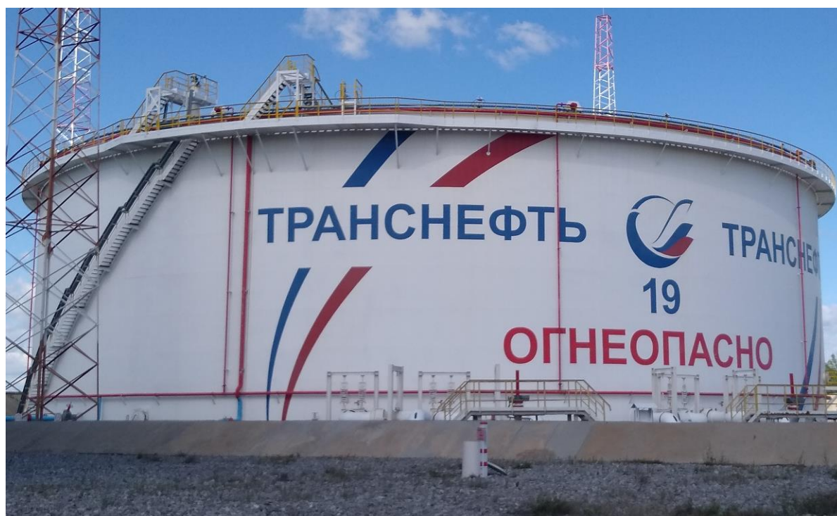
Рисунок 3 – Общий вид резервуара РВСПК-50000 с заводским номером 19
