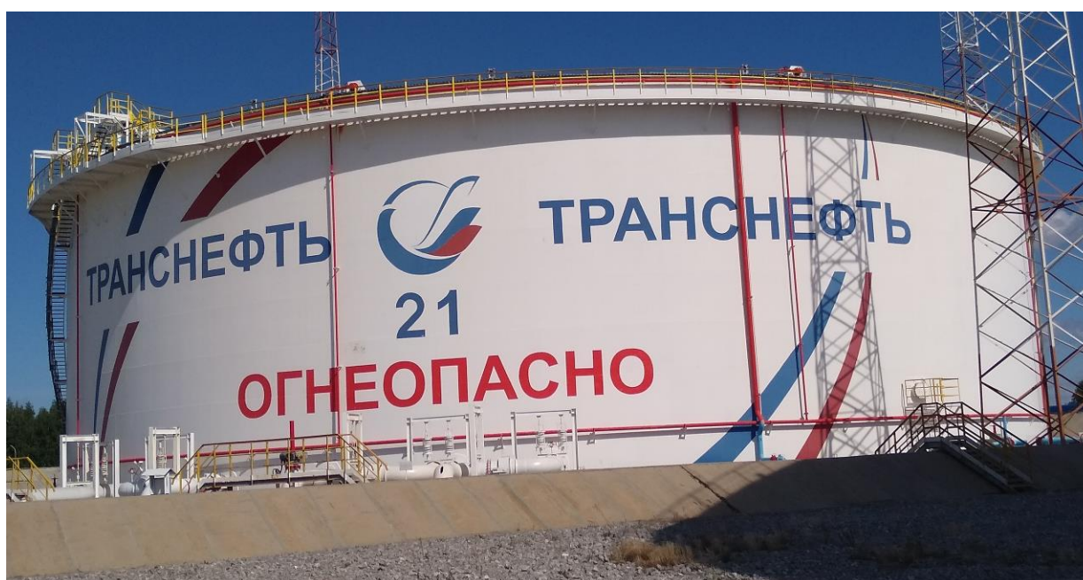
Рисунок 5 – Общий вид резервуара РВСПК-50000 с заводским номером 21
