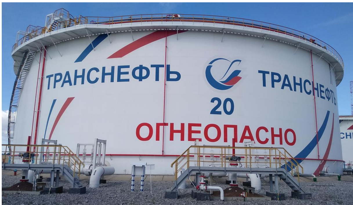
Рисунок 4 – Общий вид резервуара РВСПК-50000 с заводским номером 20
