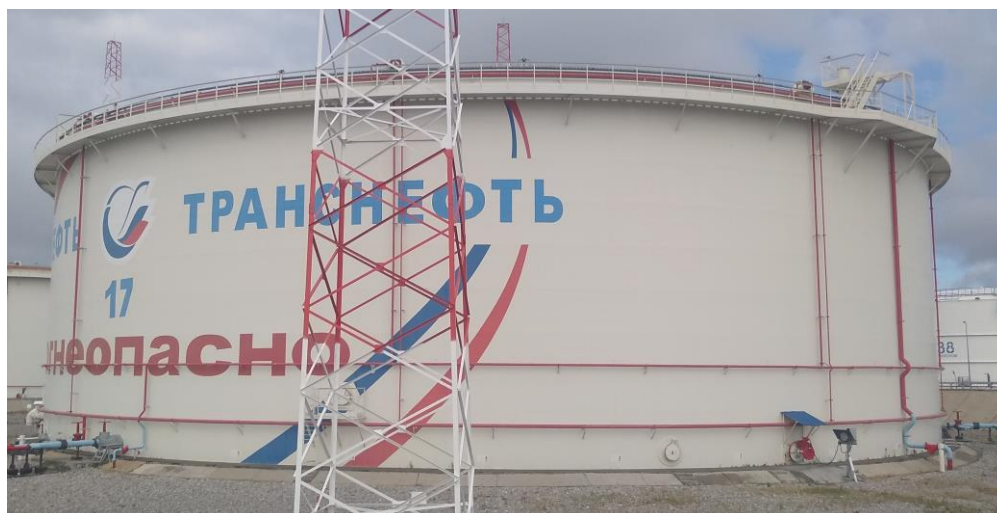
Рисунок 1 – Общий вид резервуара РВСПК-50000 с заводским номером 17
