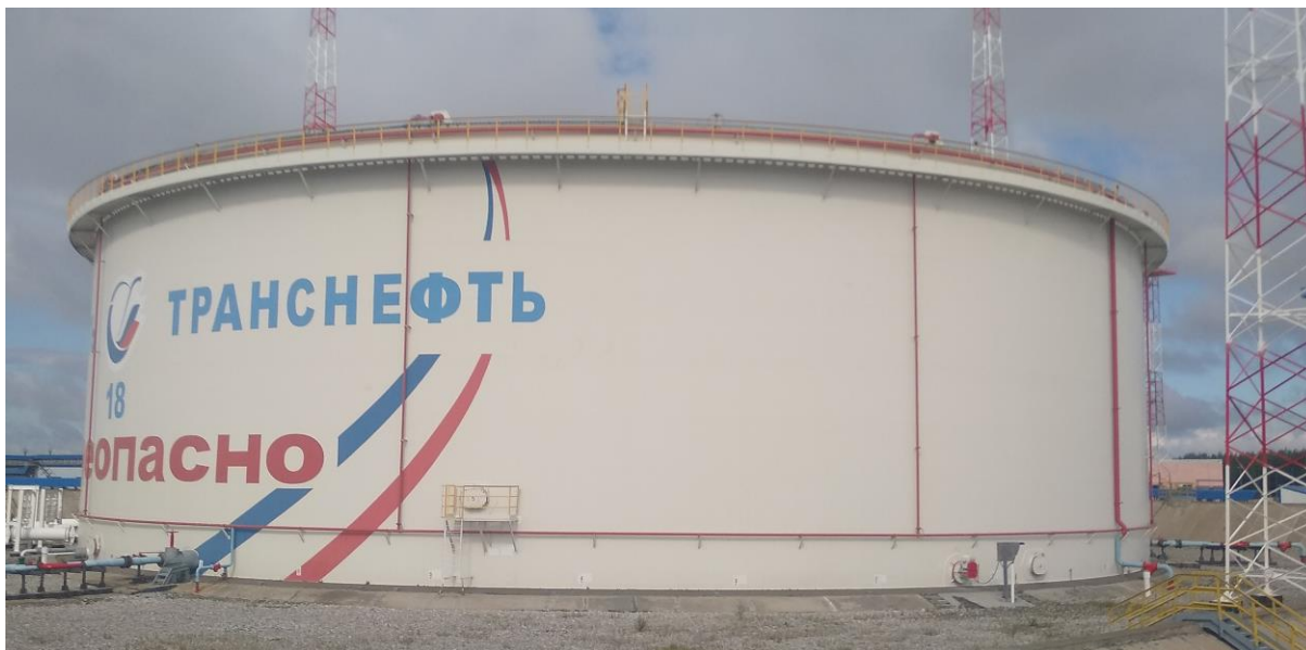
Рисунок 2 – Общий вид резервуара РВСПК-50000 с заводским номером 18
