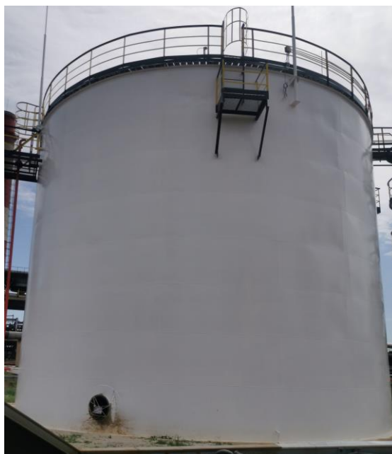
Рисунок 1 – Общий вид резервуара
