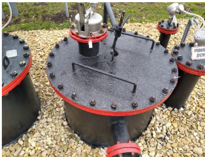
Рисунок 2 – Горловины и замерной люк резервуара стального горизонтального цилиндрического РГС-8
